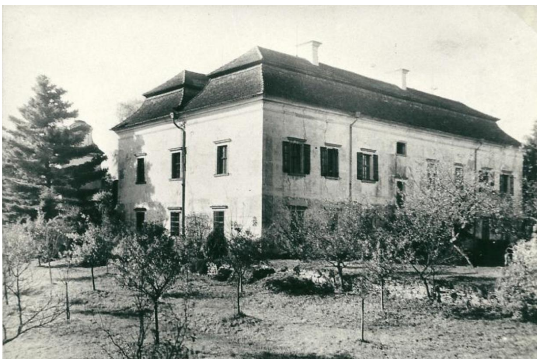
Pohled na vilu ze severovýchodní strany z 2. poloviny 20. století. Zdroj: Rabenhauptová, 2014
