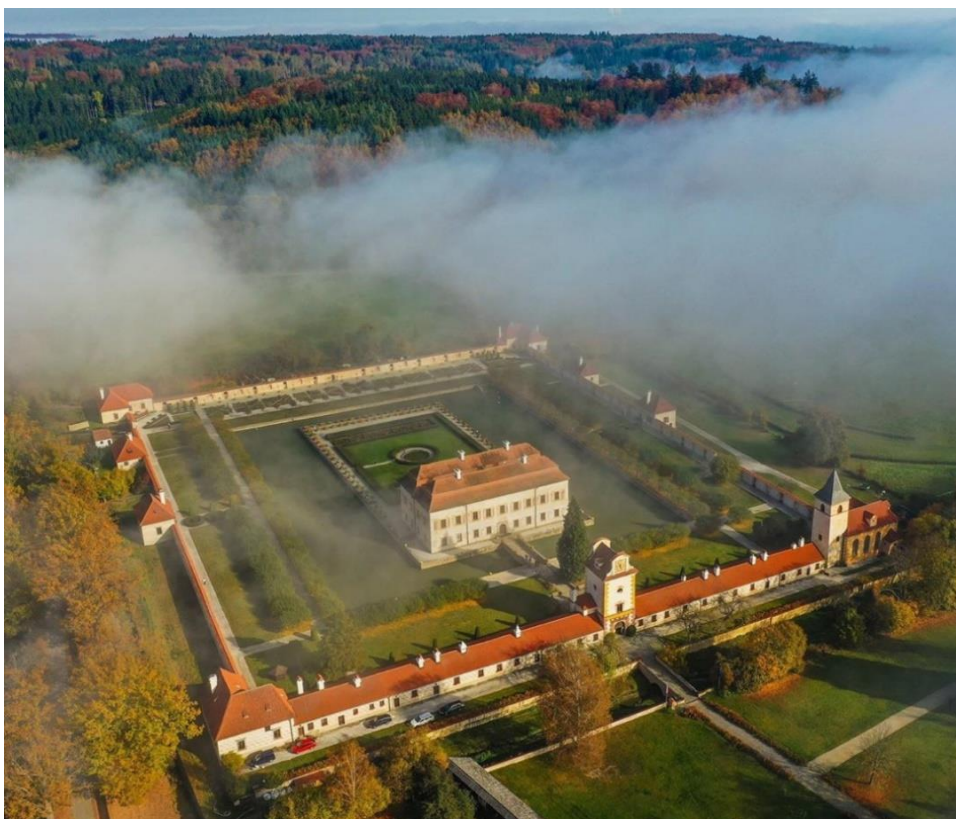
Letecký snímek zámku Kratochvíle z jižní strany zachycen v mlze. Zdroj: vlastní, 26. října 2019
