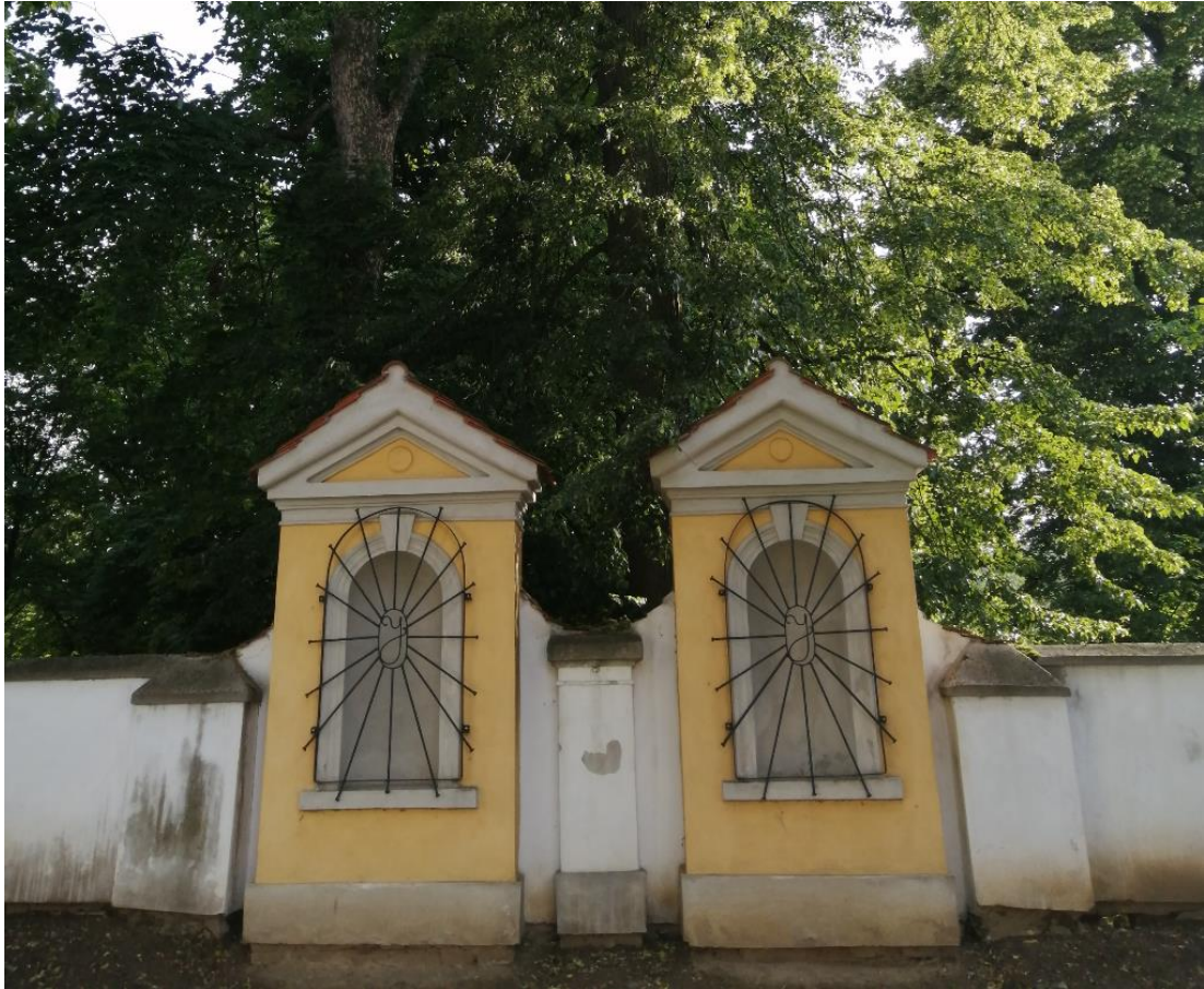
Obr. č. 30: Pohled na dvě výklenkové kaple s nikami. Zdroj: vlastní, 21. 6. 2019
