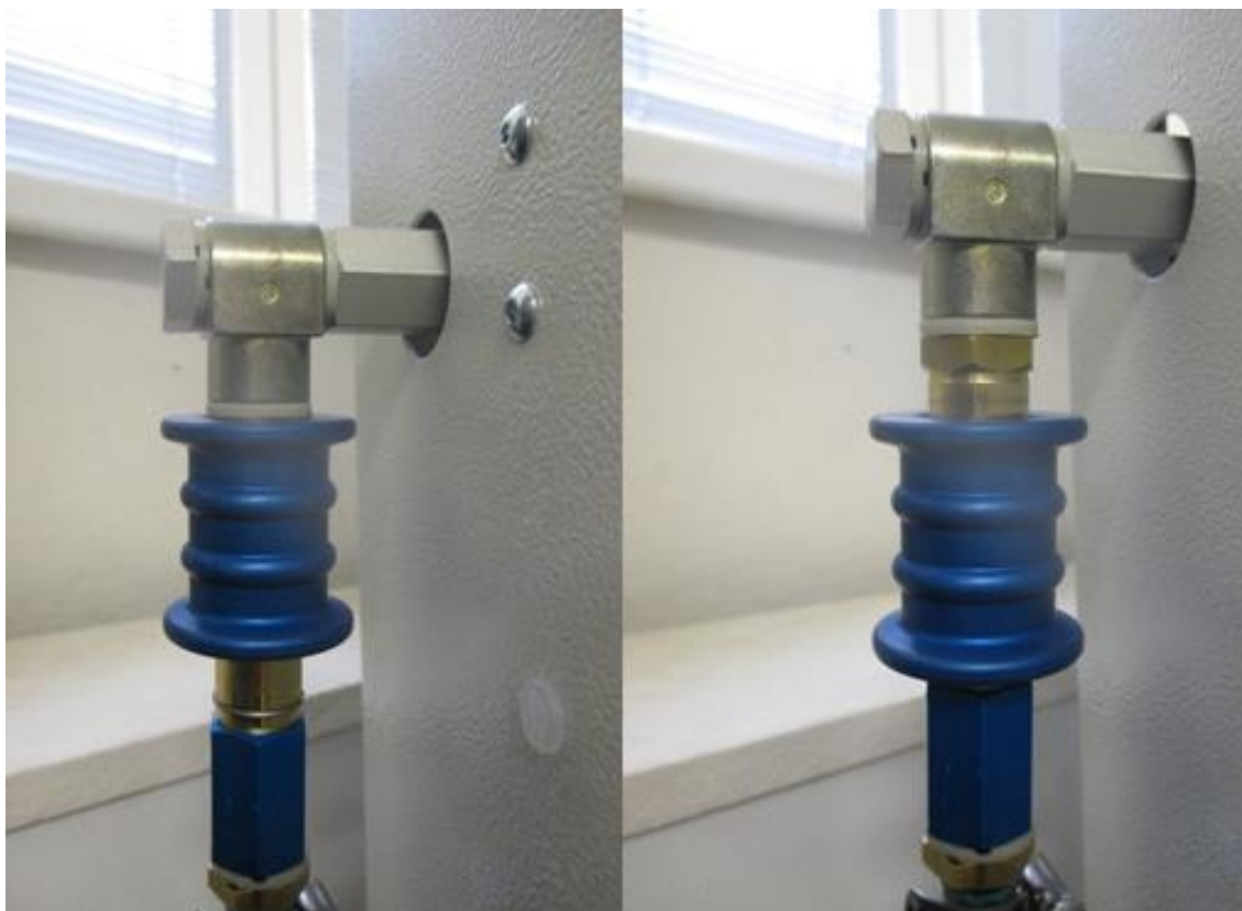
Obrázek 38 – Vstupní ventil vzduchu
