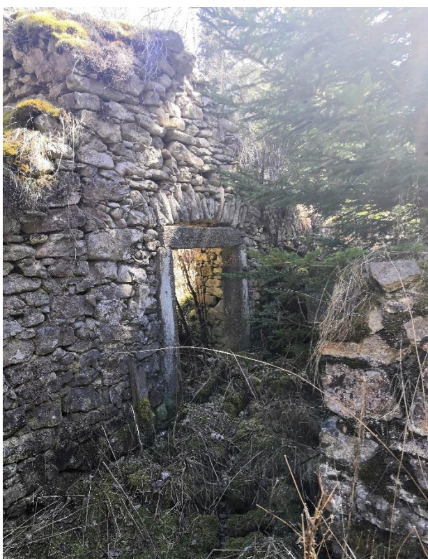
Obrázek č. 19: Kamenné zárubně v budově mlýna (zdroj: vlastní)
