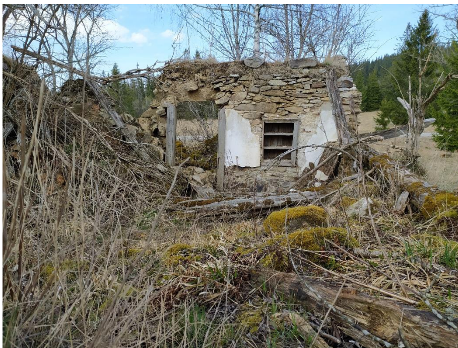
Obrázek č. 29: Dřevěné zárubně a vestavěný úložný prostor u domu č. 35 (zdroj: vlastní)
