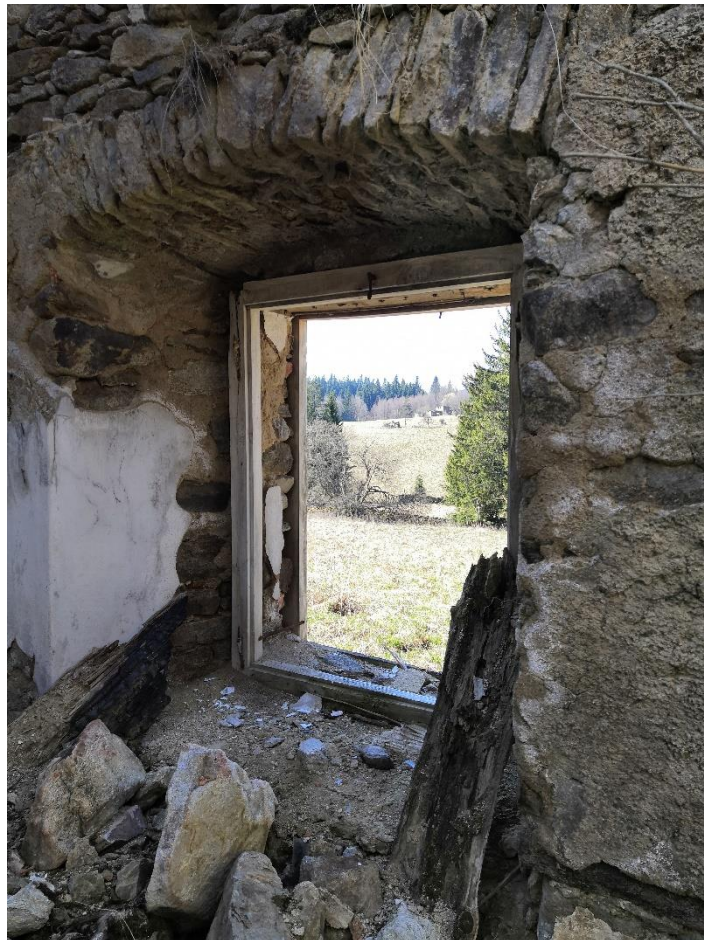
Obrázek č. 16: Detail dřevěného okenního rámu (zdroj: vlastní)
