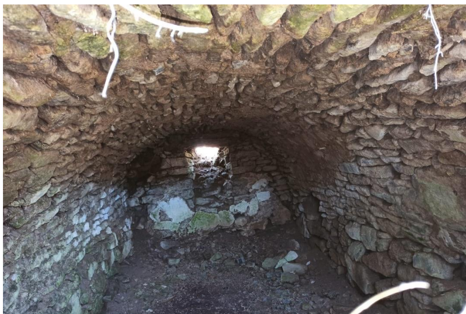
Obrázek č. 21: Sklep u domu č. 14 (zdroj: vlastní)
