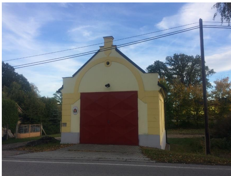
Obrázek č. 9– Opravená hasičská zbrojnice (Autor)
