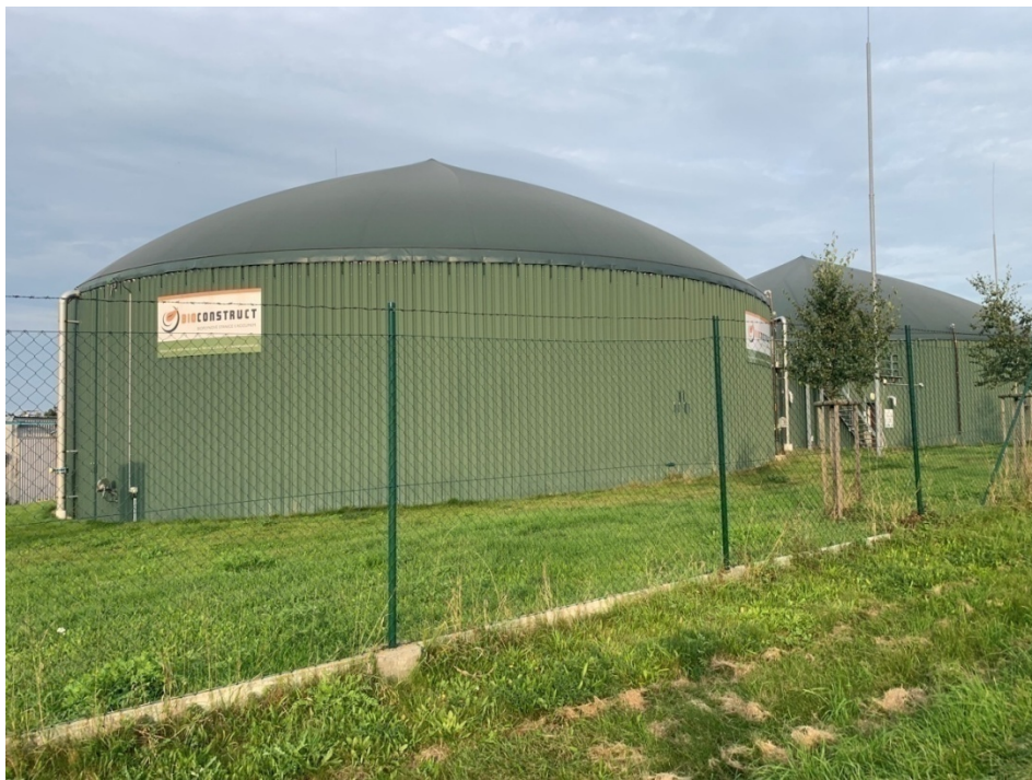
Obr. č. 10: Bioplynová stanice firmy Tilapia s.r.o.
