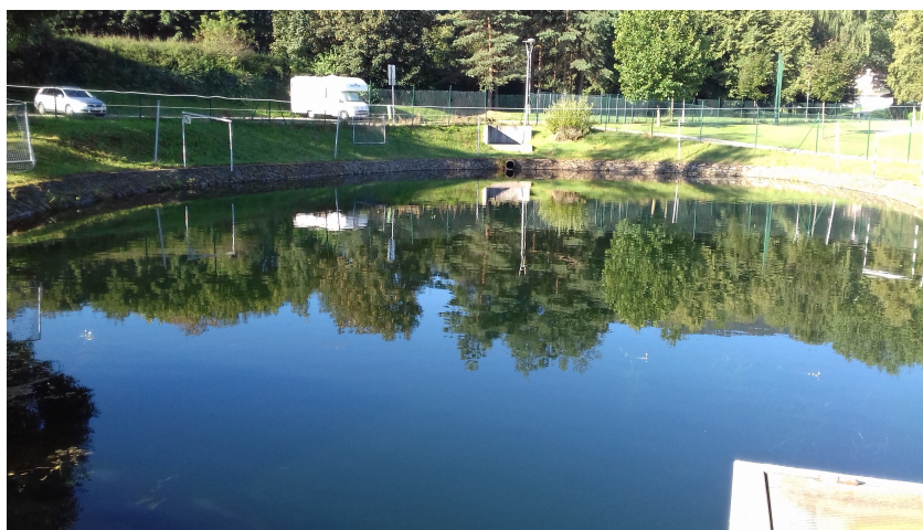
Obr. 19 – průtočná požární nádrž Hulák v Prachaticích
