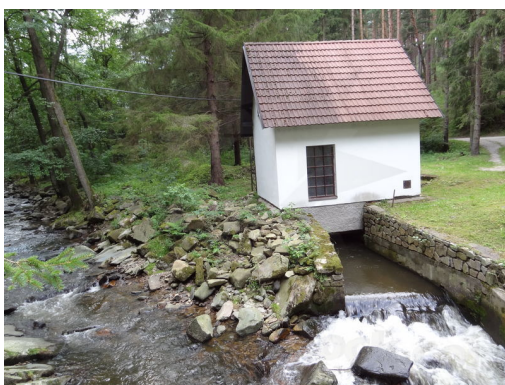
Obr. 14 – umístění MVE na menším vodním toku.
