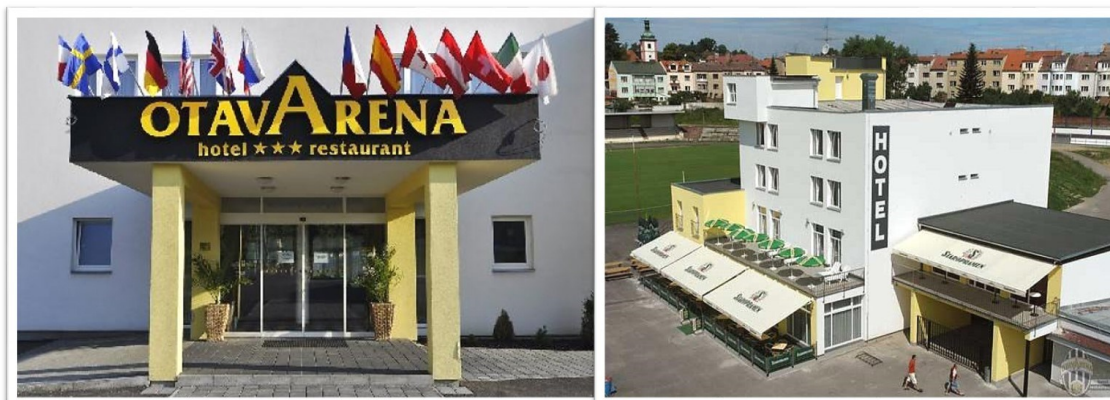
Obrázek 17. Na obrázku vlevo je pohled na hlavní vchod do hotelu Otava Arena, vpravo pohled na tento hotel z ptačí perspektivy. Soukromý archiv Františka Bořánka.
