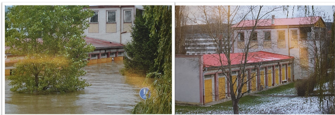
Obrázek 61. Na fotografii vlevo loděnice při záplavách v roce 2002, vpravo loděnice po následné rekonstrukci. Soukromý archiv Františka Bořánka.
