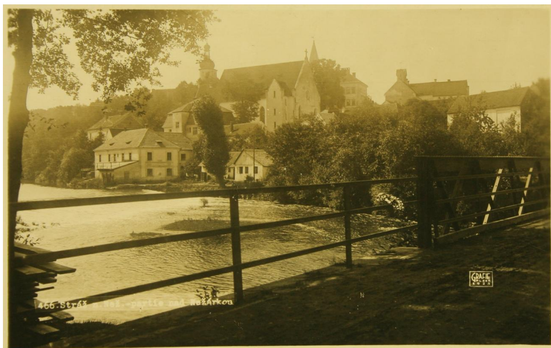
Obr. 15: Pohled z mostu v roce 1920
