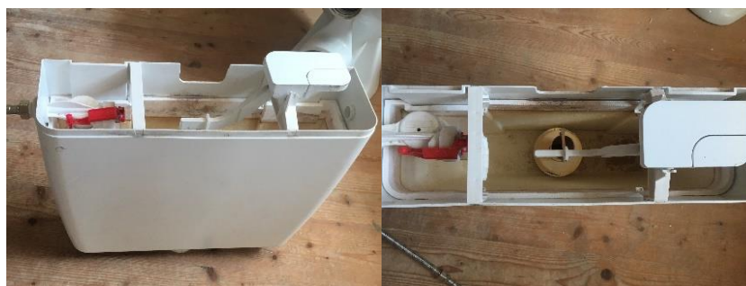
Obrázek 6 - Nádržka na vodu a její mechanismus
