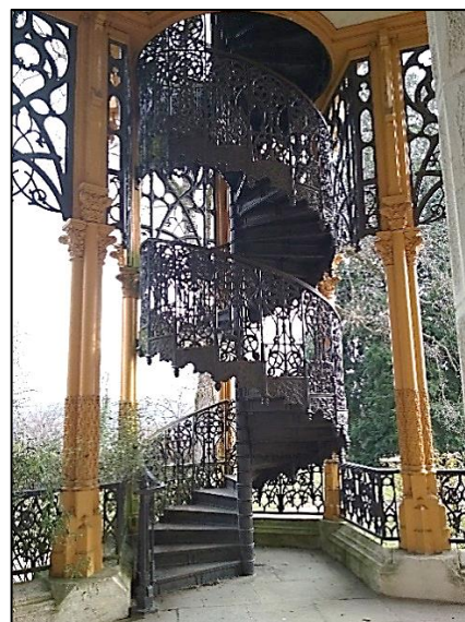
Obr. 98: Točité schodiště na zámku Hluboká
