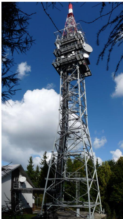
Obrázek 7: Televizní a rozhlasový vysílač na Strážišti
