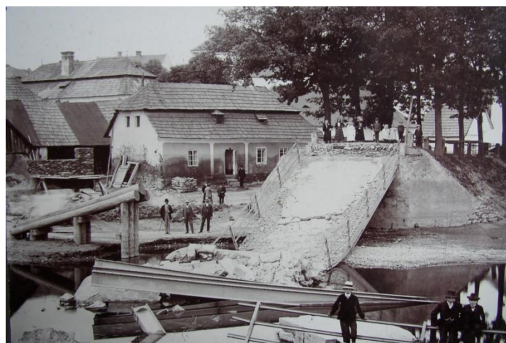
Obrázek 2: Zřícený most po povodni.
