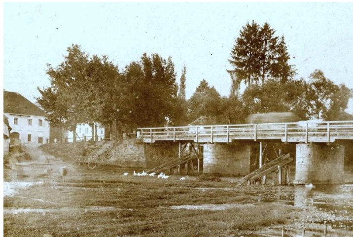
Obrázek 1: Traverzový most zničený povodní v roce 1911.
