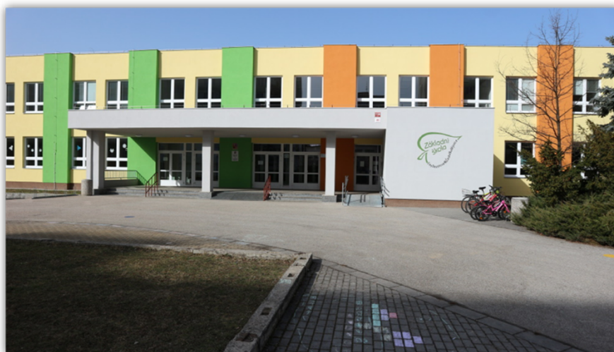
Obrázek 88. ZŠ Emy Destinové – hlavní budova (Zdroj: www.destinka.cz 2021).
