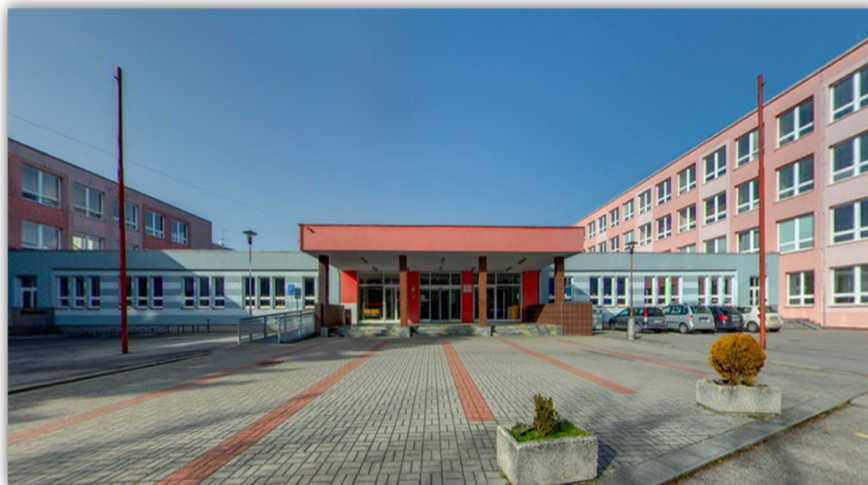
Obrázek 68. ZŠ Bezdrevská – hlavní budova (Zdroj: www.zsvltava.cz 2021).
