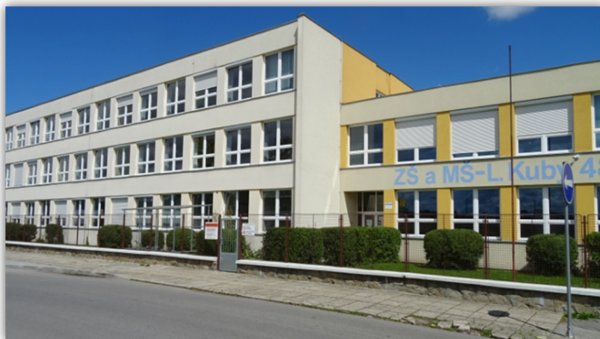
Obrázek 27. ZŠ L. Kuby – hlavní budova (Zdroj: www.zsroznov.cz 2021).
