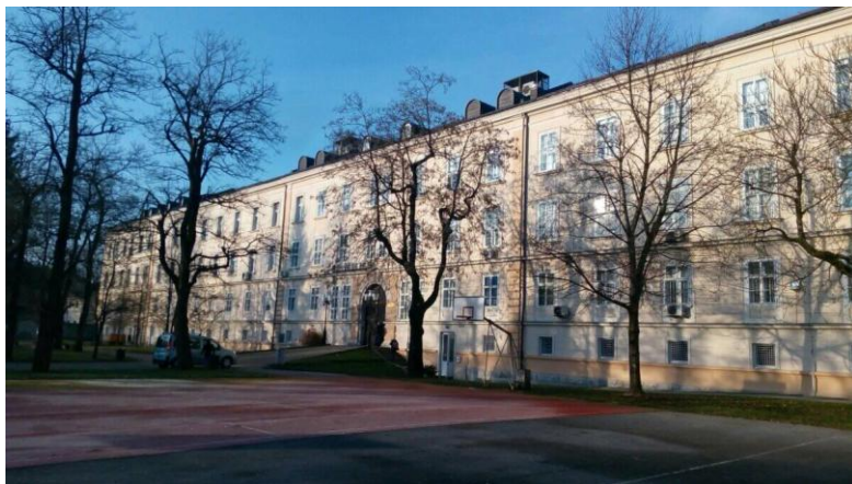
Obr. č. 12 Budova střední hospodářské školy Ljubljana, převzato a upraveno z [2]
