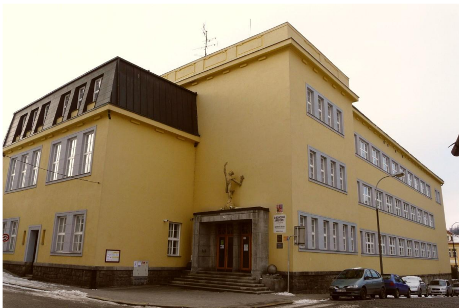
Obr. č. 1 Budova OA TGM Jindřichův Hradec, převzato a upraveno z [1]
