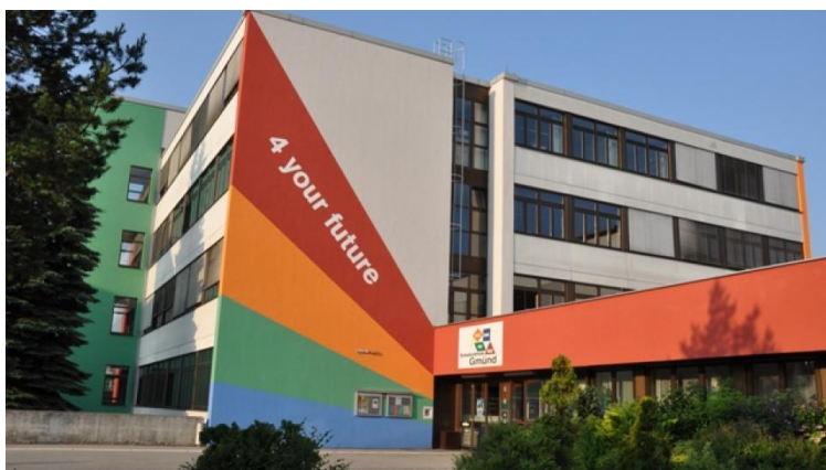
Obr. č. 8 Budova OA Gmünd, převzato a upraveno z [2]
