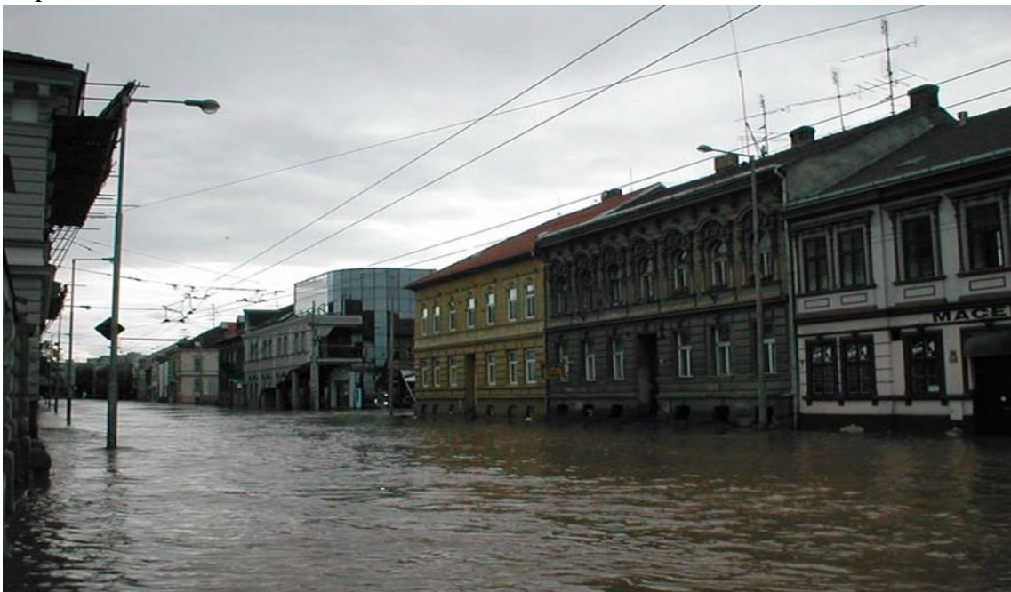
Obrázek 7 Povodně 2002 ČB, Pražská třída-před budovou stávajícího KŘ a OPIS HZS JčK
