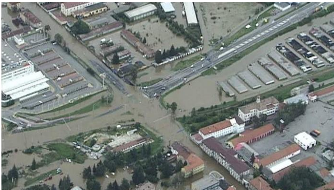
Obrázek 8 Povodně 2002 ČB, křižovatka ulic Pražská a Strakonická - letecký pohled
