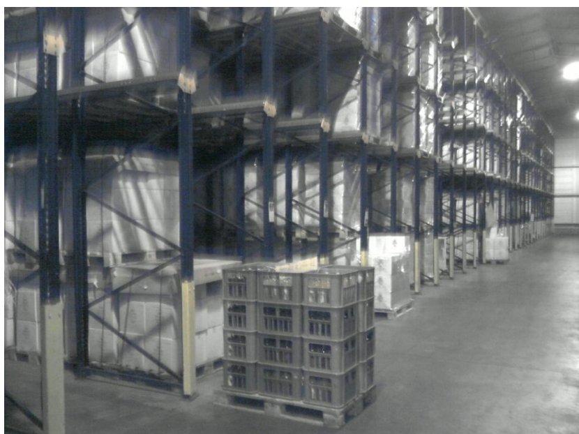
Obrázek 9: Skladové prostory společnosti Fruko – Schulz s r.o. (2. část)
