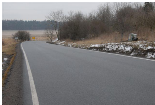
Obrázek 8: Rekonstrukce silnice III/2385
