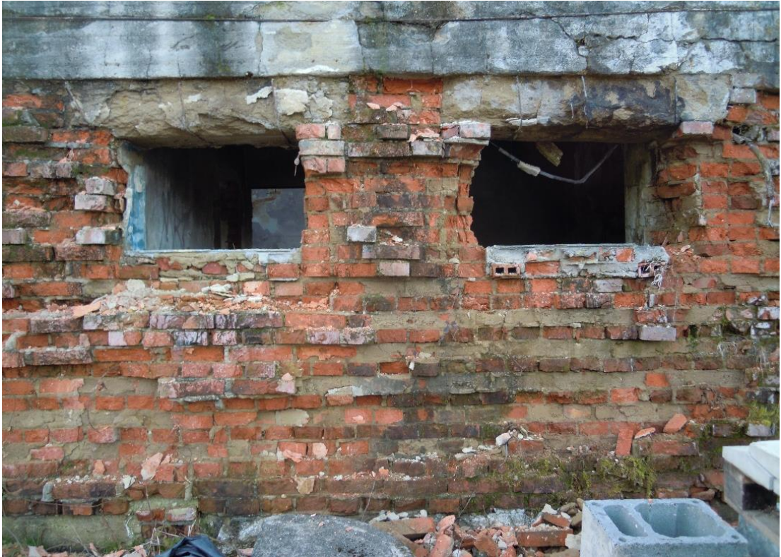
Obrázek 4.9 – Detail na rozpadávající se zdivo (vlastní)
