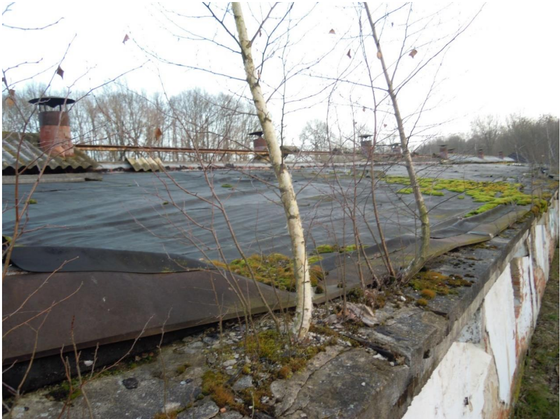
Obrázek 4.13 – Detail na střešní plášť (vlastní)
