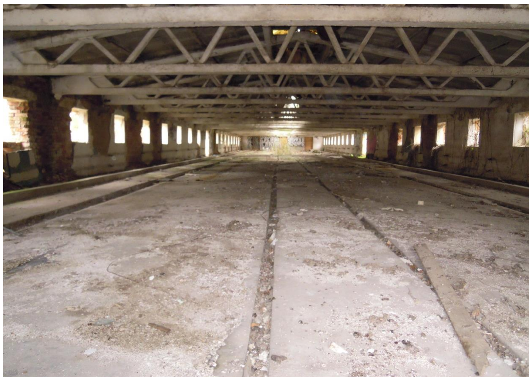
Obrázek 4.11 – Betonová podlaha s drážkami pro odvod nečistot a výkalů (vlastní)
