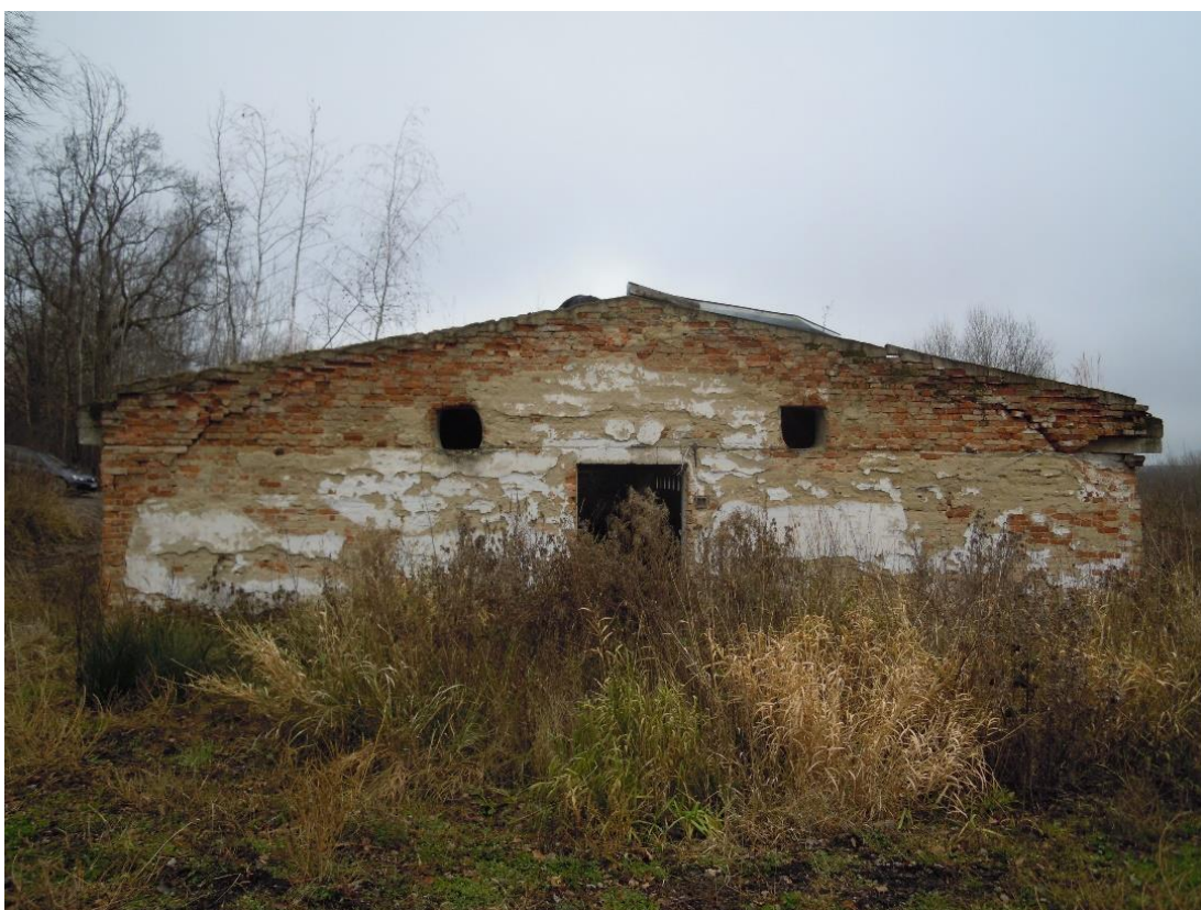
Obrázek 4.8 – Jižní pohled na štít objektu (vlastní)
