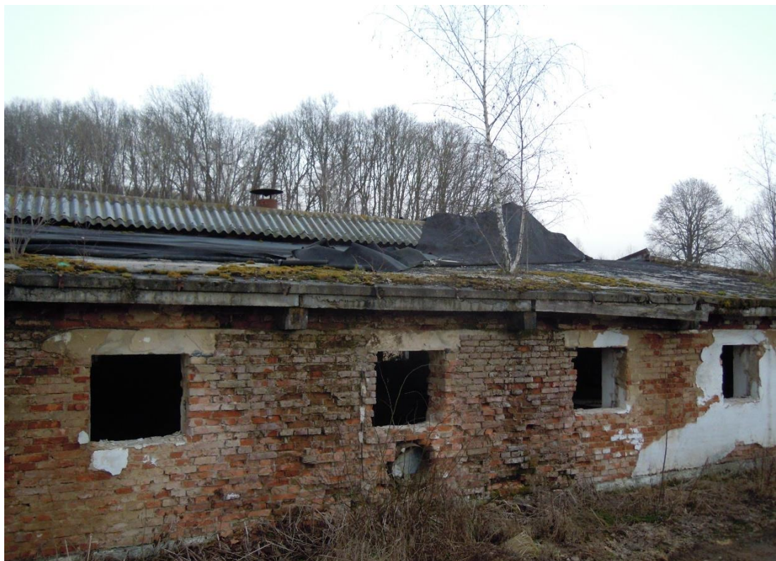
Obrázek 4.14 – Detail na zdivo pod nosníky (vlastní)
