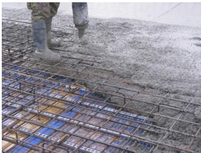
Obr. 7 Ukázka výroby železobetonu (Hennlich, 2021)
