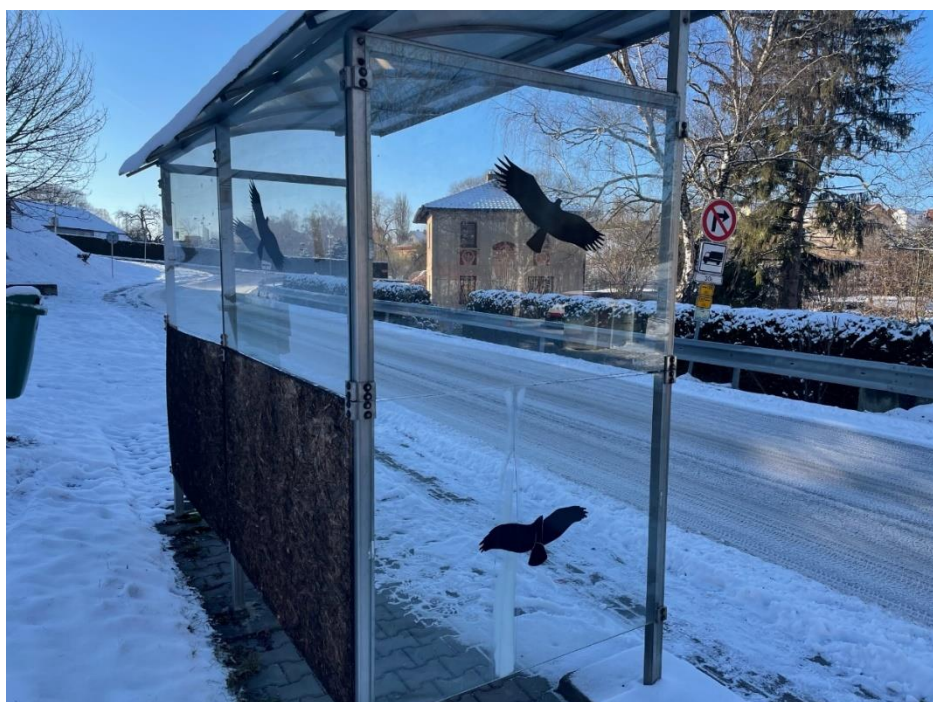
Obrázek č. 13 – Ukázka nedostatečného polepu siluet ptáků na autobusové zastávce.
