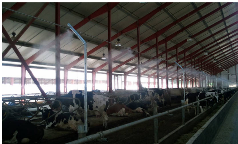
Obrázek 2.3: Umístění skrápěcích trysek
