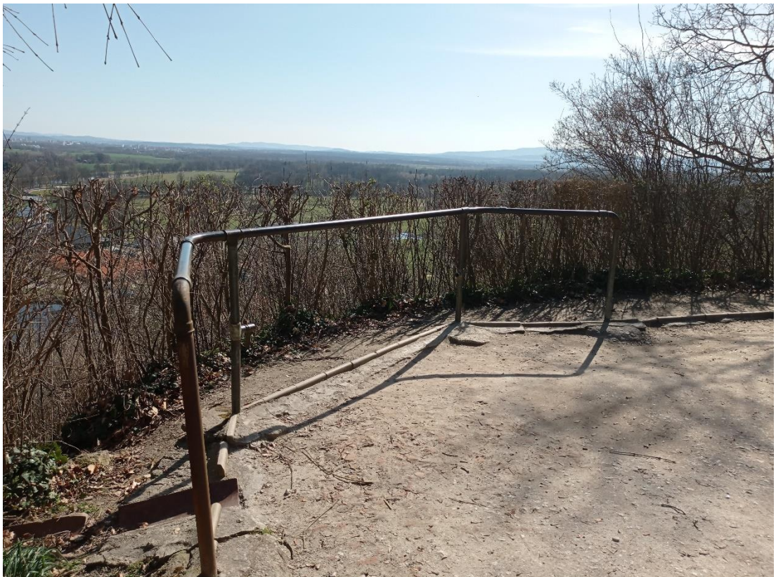
Příloha 51: Zábradlí v dolní zahradě (Vlastní)
