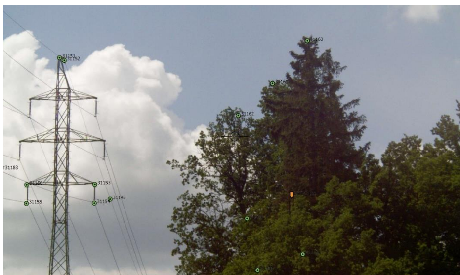
Obrázek 4.27: Zaměřený stožár VVN (vlastní)
