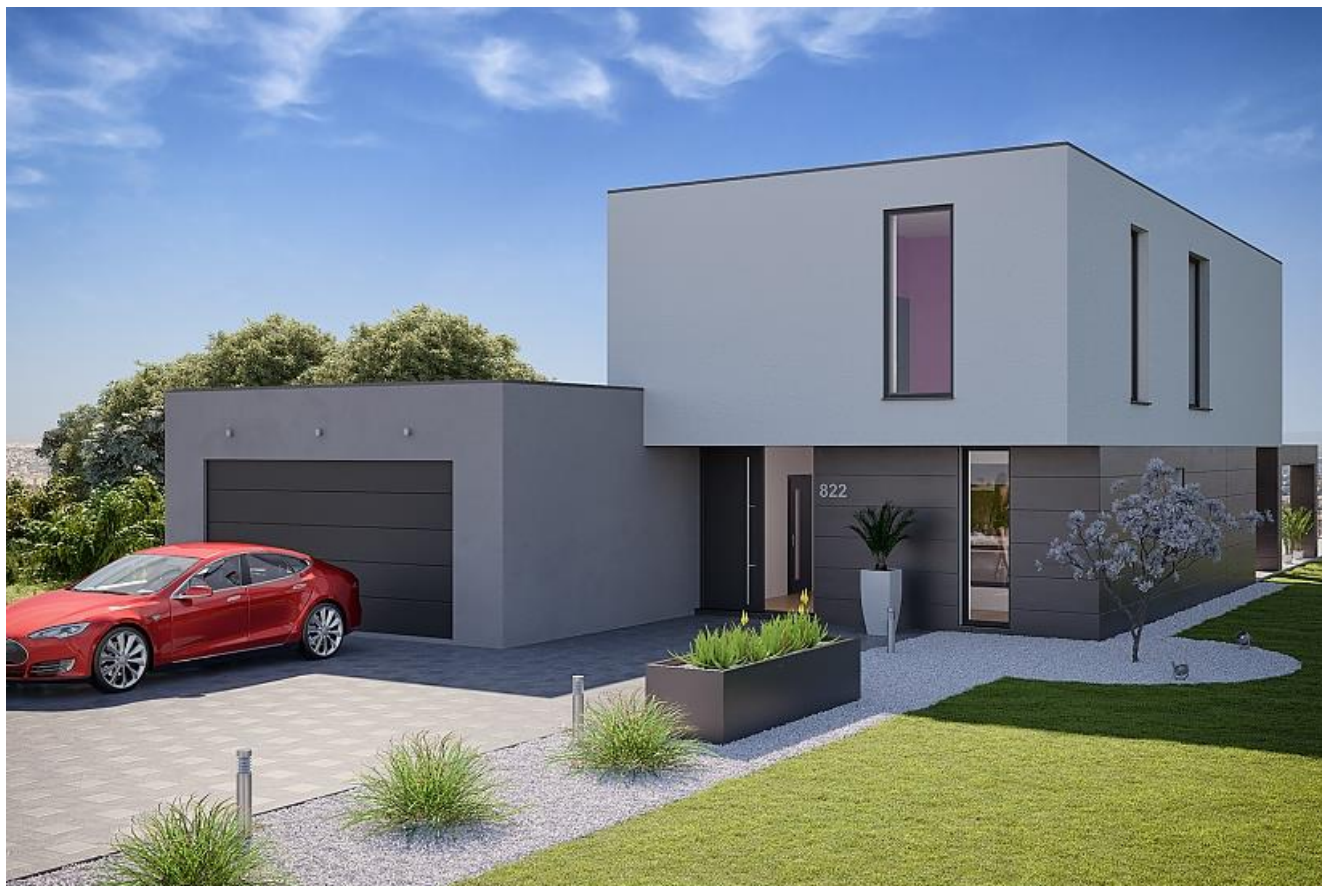
nevhodný příklad stavby
