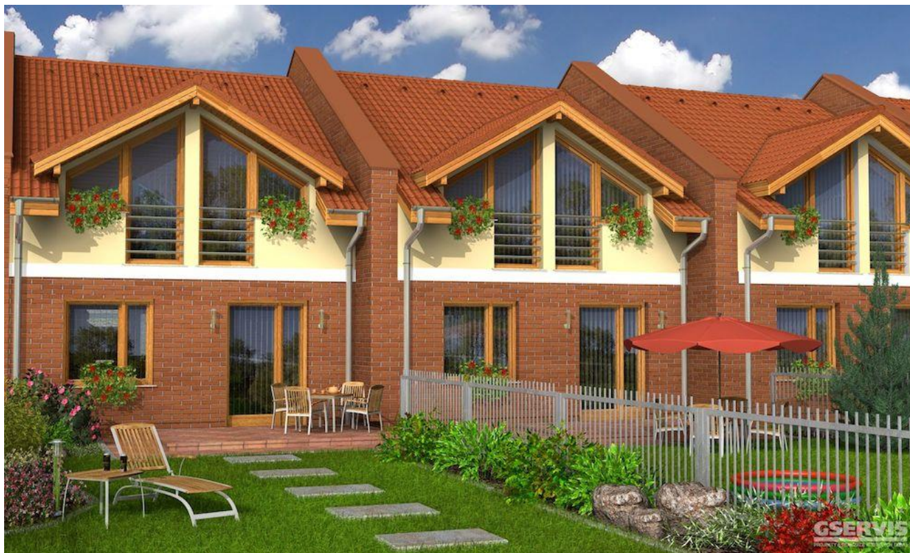
nevhodný příklad stavby
