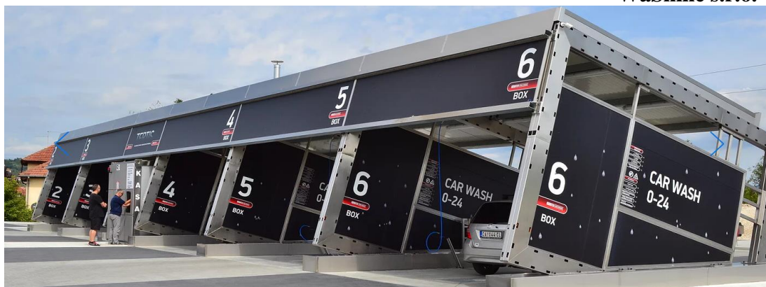
Samoobslužná automyčka firmy Washine s.r.o. ( https://www.washine.cz/ )
