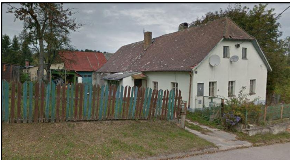
Obrázek 7.4: Foto nemovitosti (Google Street View, 2021)
