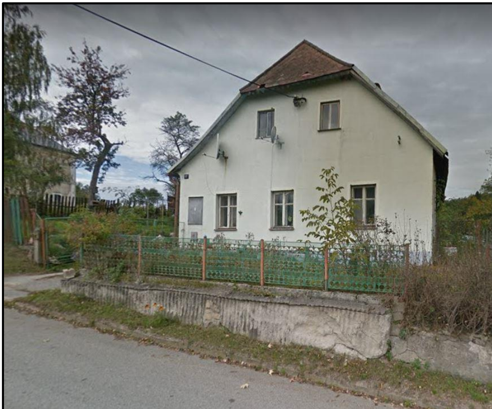
Obrázek 7.3: Foto nemovitosti (Google Street View, 2021)
