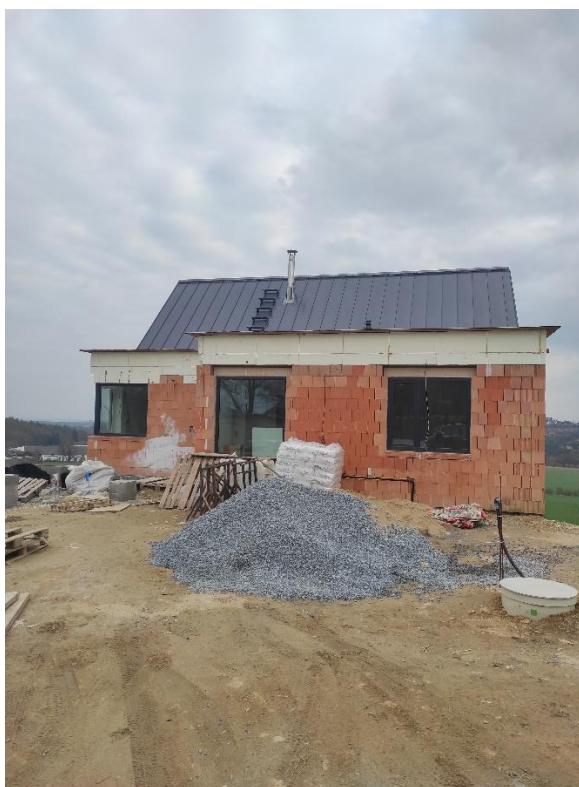
Obrázek 2.5 - Aktuální fotografie stavby (Zdroj: vlastní, 2021)
