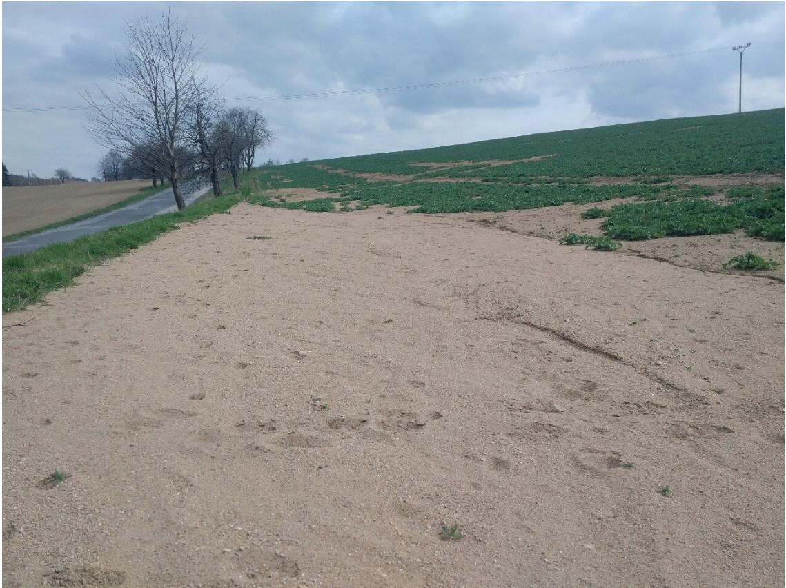
Obr. č. 12, 13, 14, 15 Eroze půdy hon č.3
