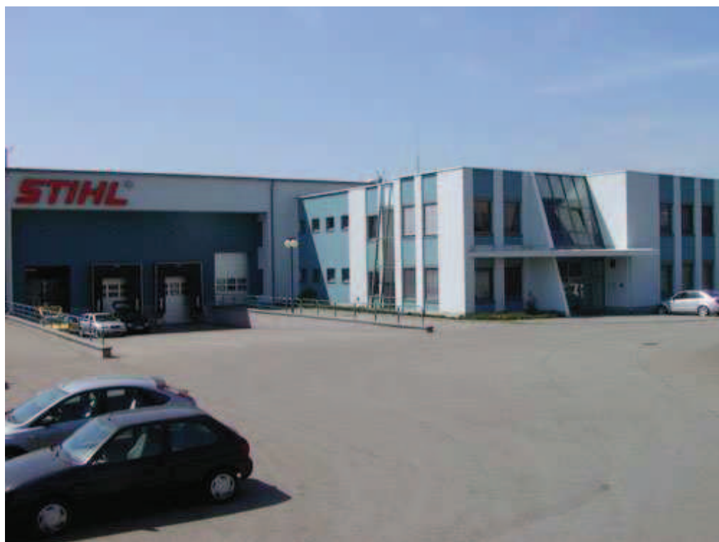
Obrázek 12 - Distribuční středisko firmy STIHL otevřené roku 1999 v Modřicích, ČR
