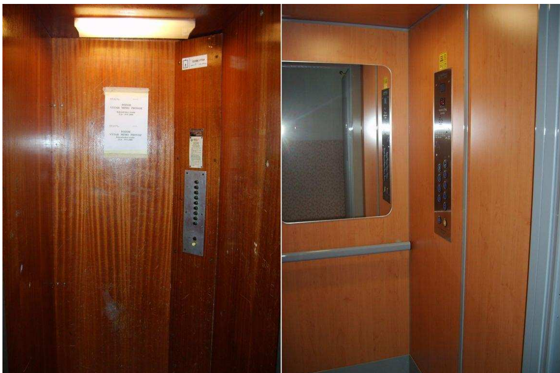
Obrázek 5 – Kabina výtahu před a po modernizaci
