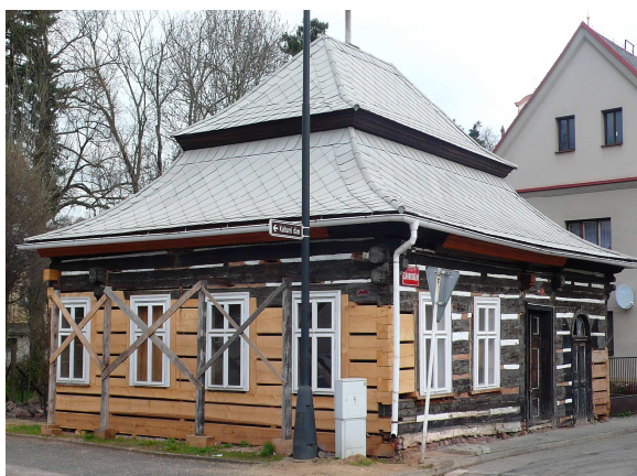
budova č. 166 – Nová Paka
