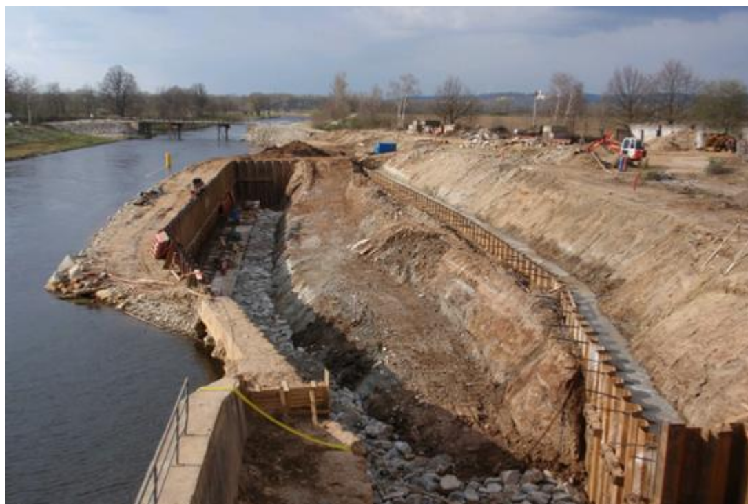
Obr. č. 6: Druhá část plavební komory – současný stav
