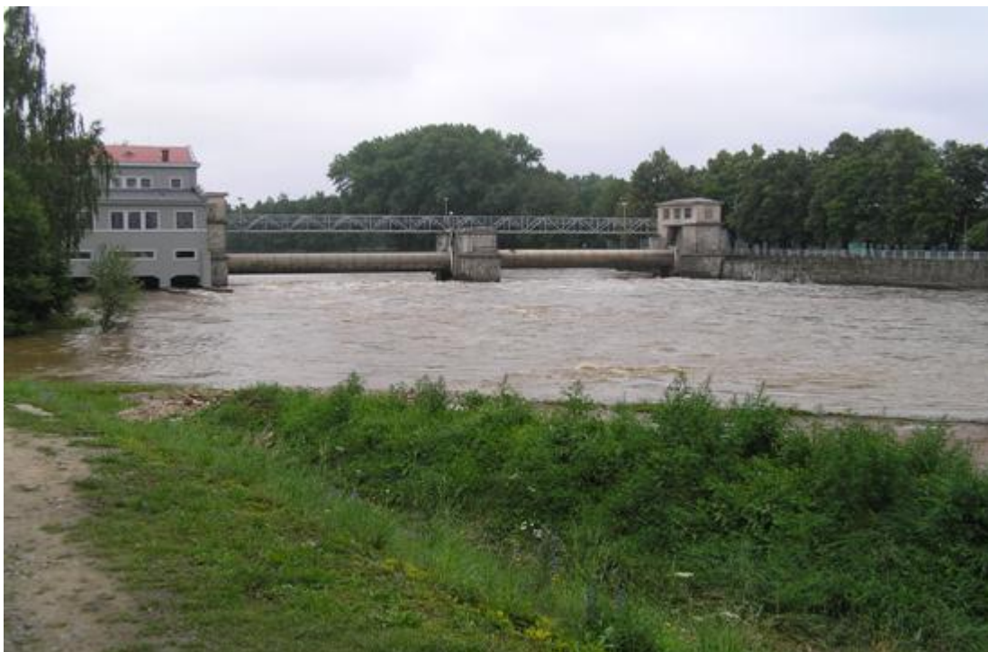
Obr. č. 12: Obratiště pod Jiráskovým jezem - povodeň
