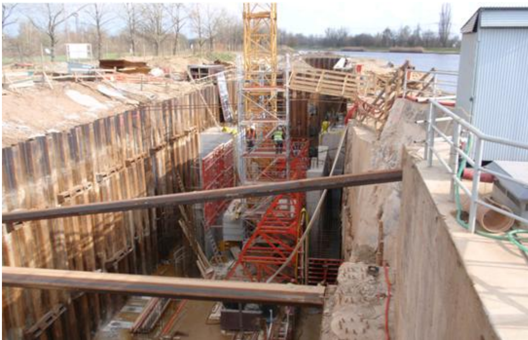
Obr. č. 5: První část plavební komory – současný stav
