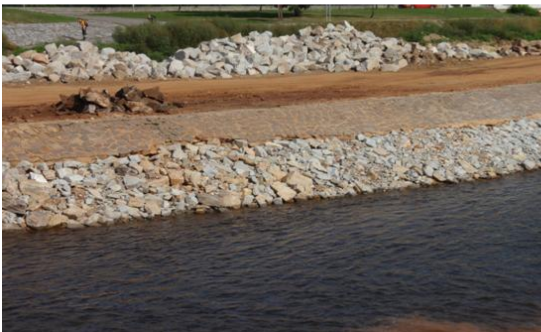
Obr. č. 11: Protipovodňová opatření
