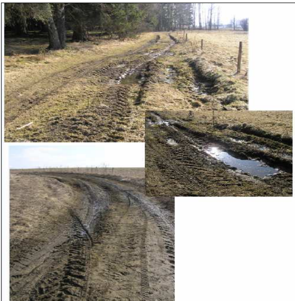
Obrázek 39. Rozsah poškození povrchu naučné stezky A. Stiftera, Horní Planá.
