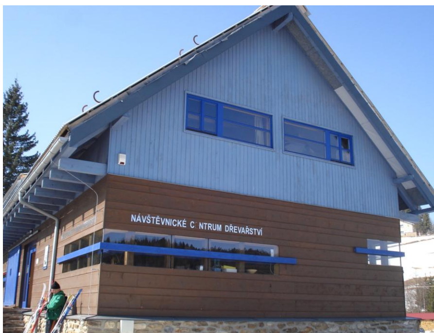
Obrázek 7 budova Návštěvnického centra dřevařství na Modravě
