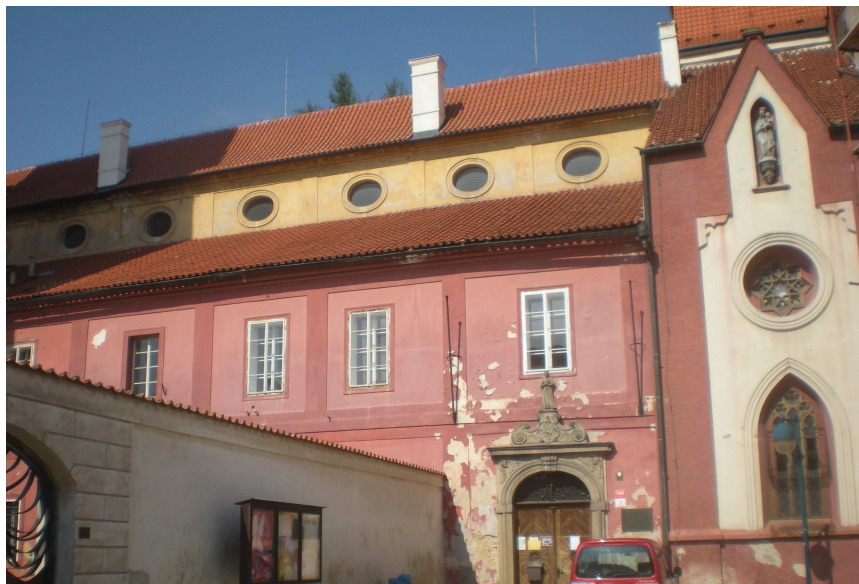
Budova bývalé Okresní finanční správy v Českých Budějovicích. Piaristické nám. č. 1:
