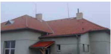
Obec Zvotoky / Rekonstrukce střechy víceúčelového zařízení v obci Zvotoky / 837 900 Kč / 394 960 Kč
