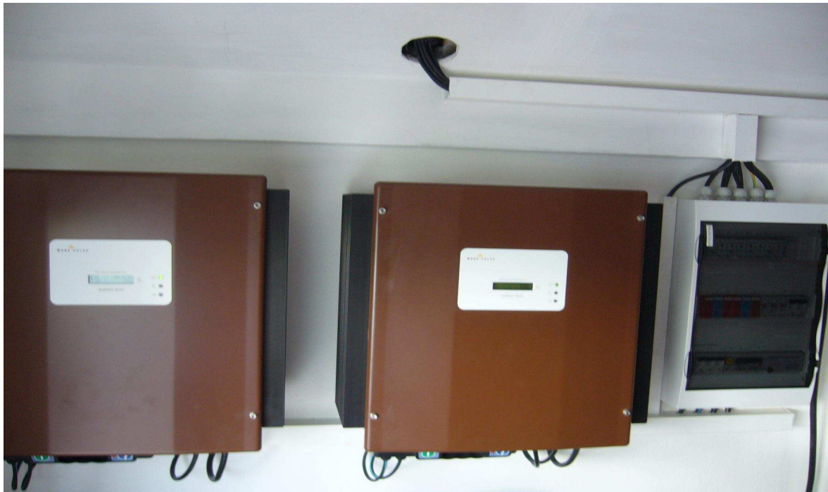
Obrázek 1 Střídače SMA Sunny Boy SB 3300TL HC
