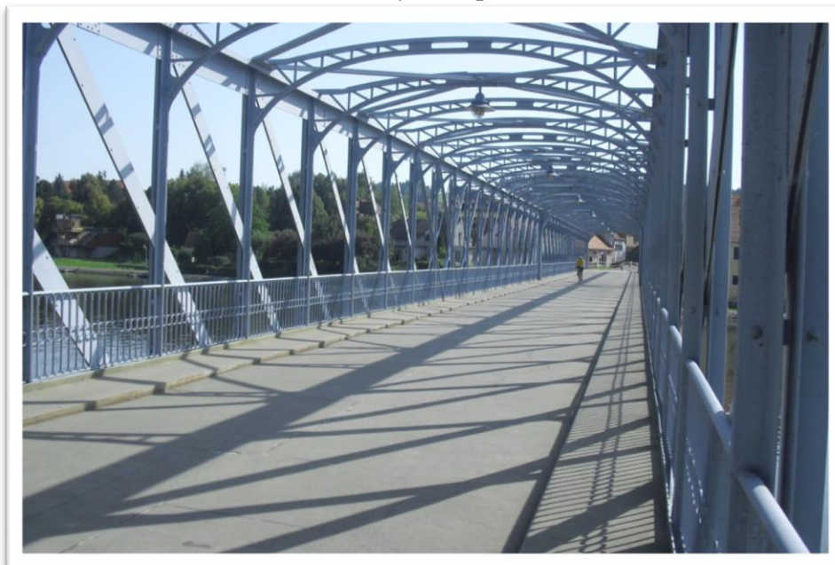
Obrázek:č.3 Ocelový most přes řeku Vltavu
