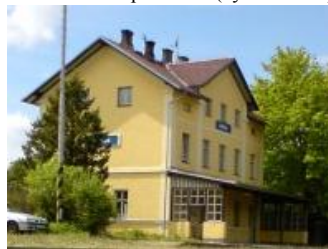
Obr. 4: Budova penzionu (býv. nádraží)
