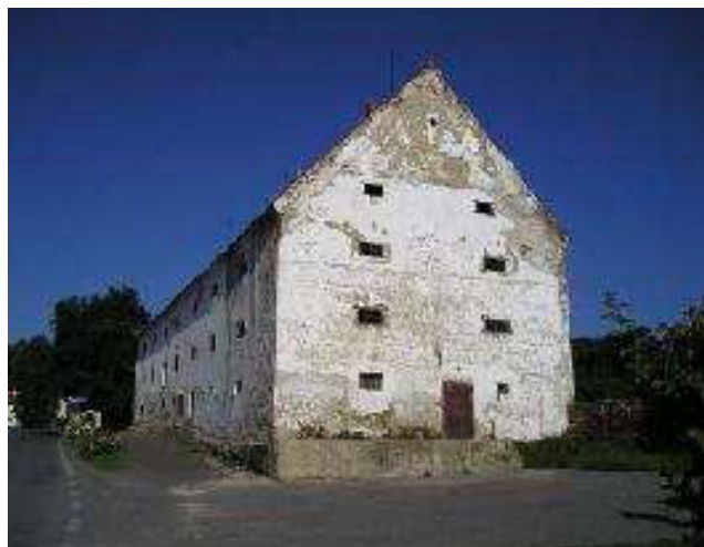
Obrázek 1: Špýchar v Čížové před rekonstrukcí, zdroj: CzechInvest
