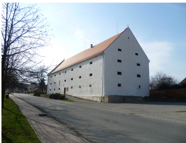
Obrázek 2: Špýchar v Čížové po rekonstrukci, zdroj: vlastní
