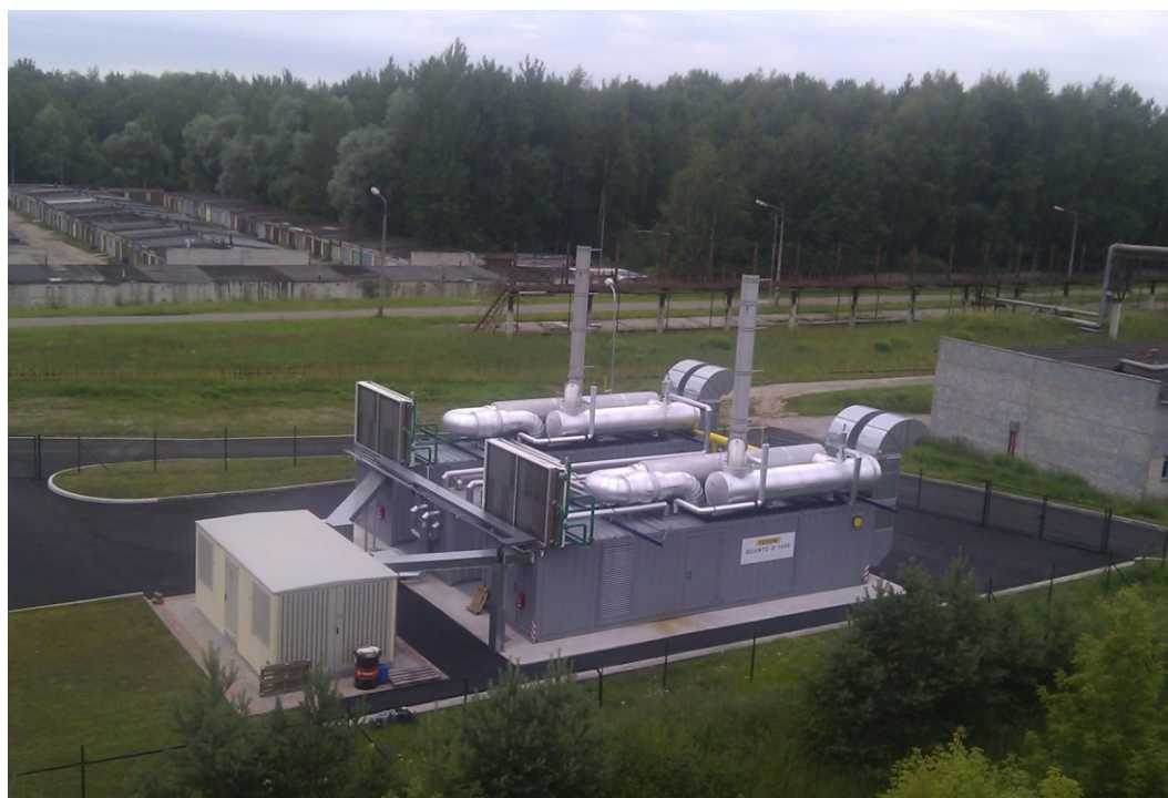
Obrázek 3: Příklad kogenerační jednotky od české firmy TEDOM
