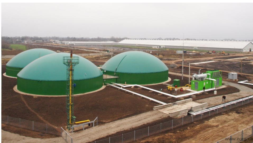
Obrázek 2: Příklad bioplynové stanice na bázi mokré fermentace
