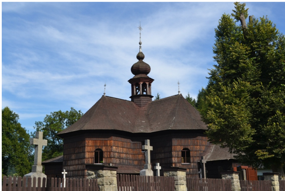
Obrázek 10: Dřevěný kostelík ve Velkých Karlovicích
