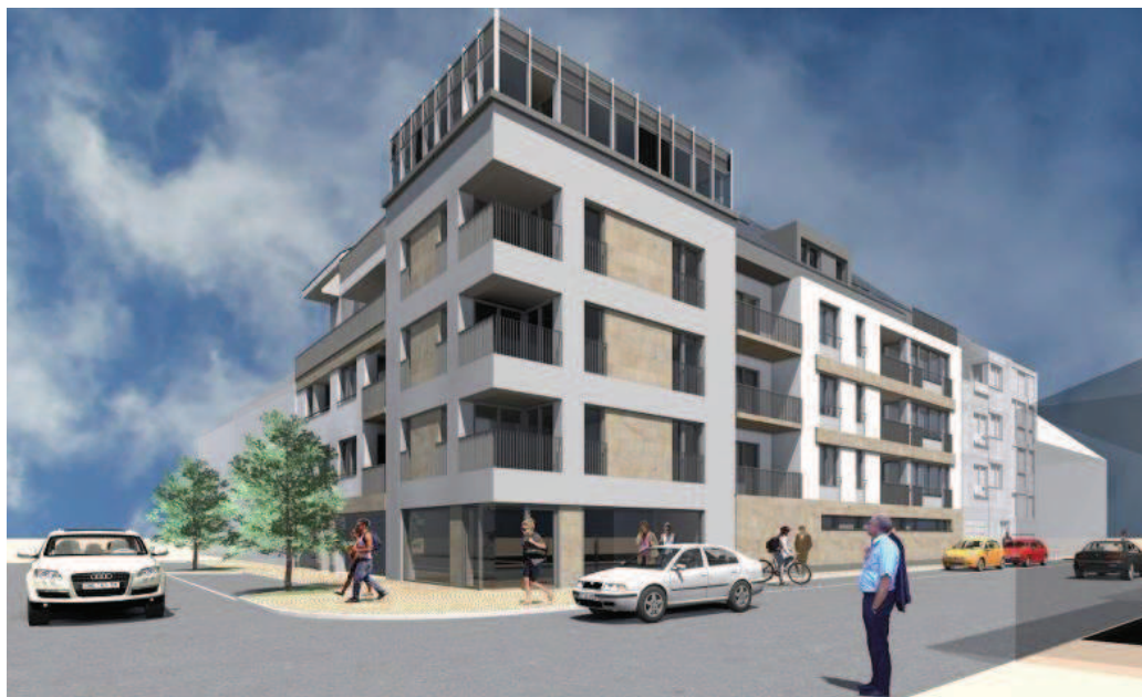
Obrázek 7 Bytový dům Smetanova
