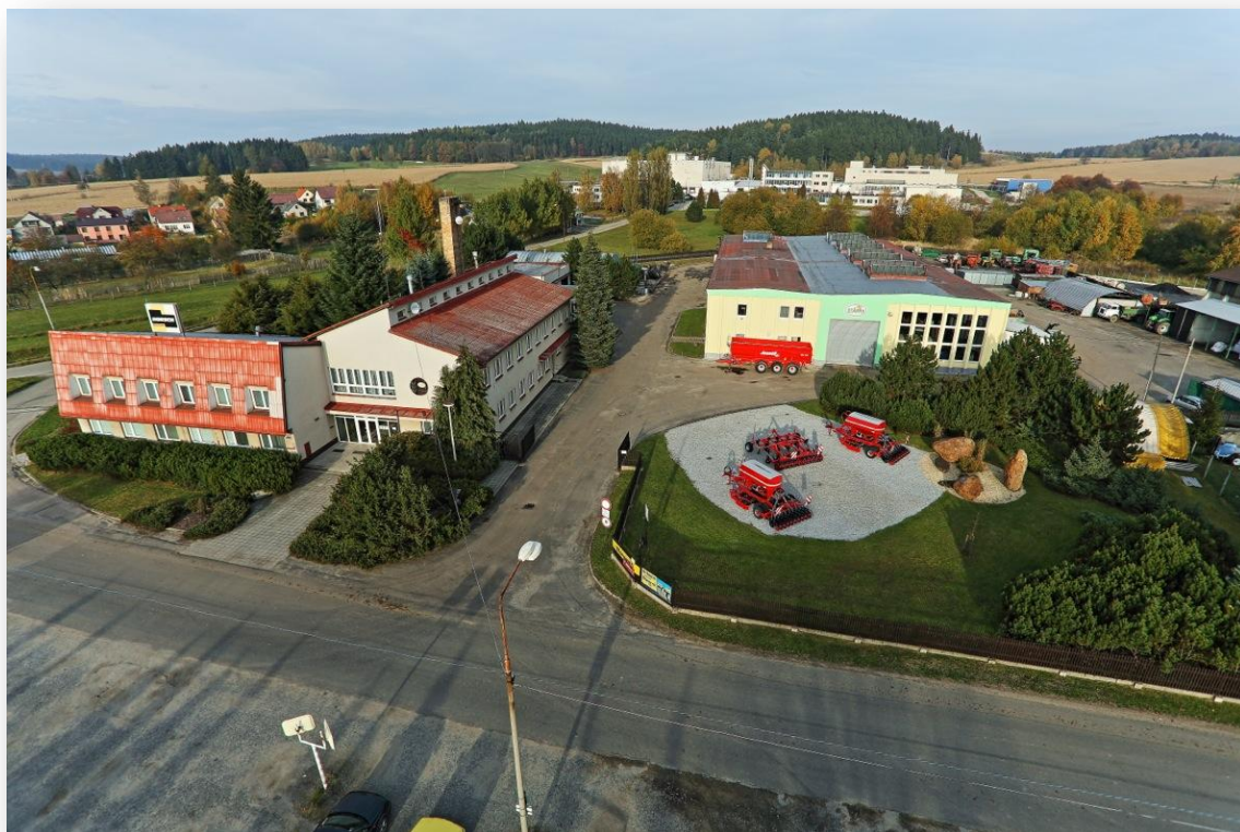
Příloha 5: Letecký snímek sídla firmy STAGRA s. r. o.
