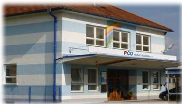
Obrázek 15 – Budova PCO, s.r.o. v Českých Budějovicích
