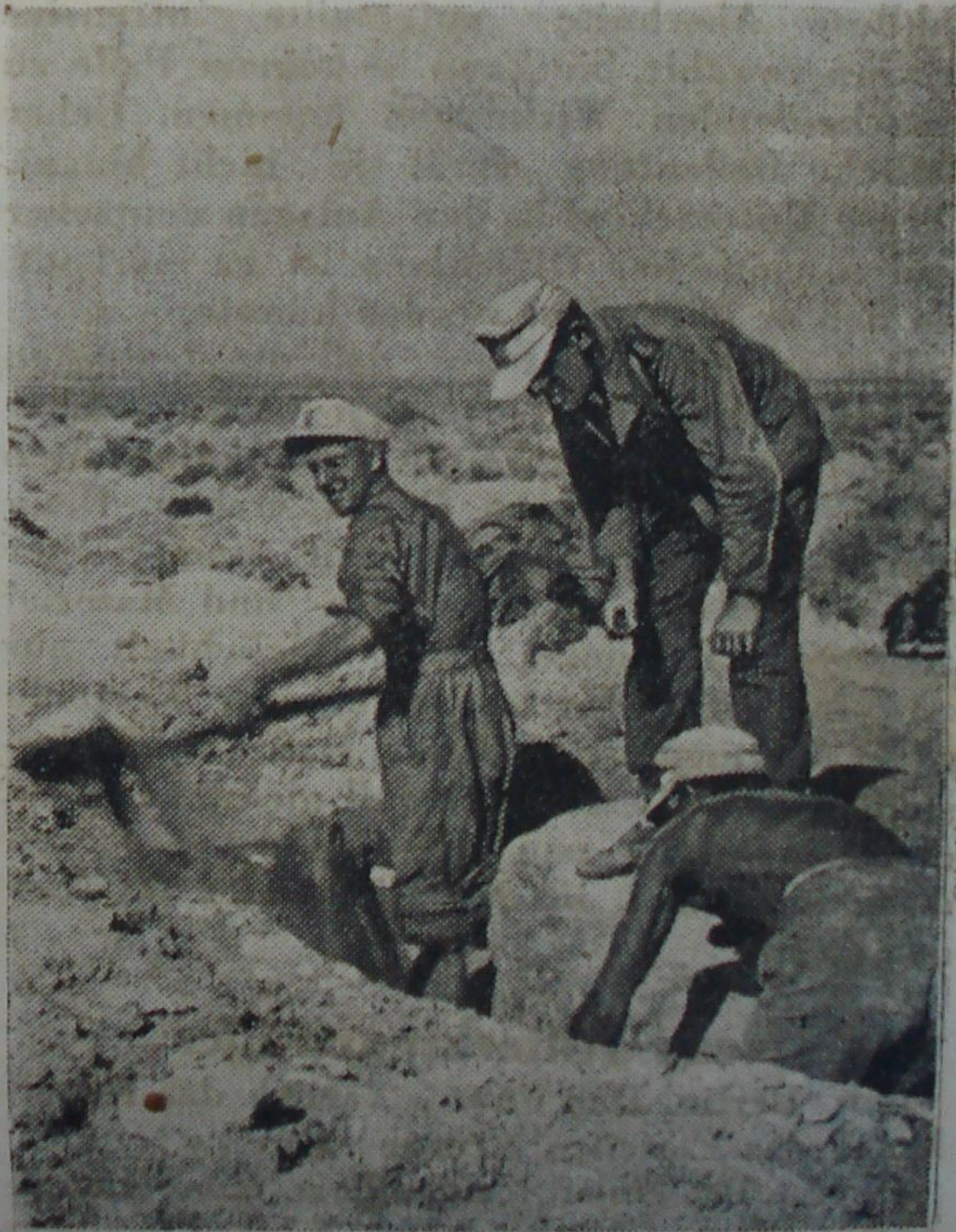
Stellungsbau an der libyschen Front In dem deckungsarmen Wüstengelände müssen die Infanteriestellungen tief in den sandigen und steinigen Boden gebaut werden. PK.-v. Troschke, (PBZ.-Sch.)
