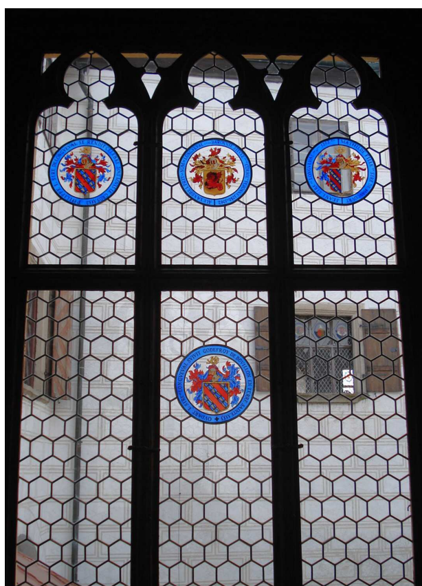
Obr. 22: Křižácká galerie v Rožmberku nad Vltavou: Současný stav vitrážového okna
