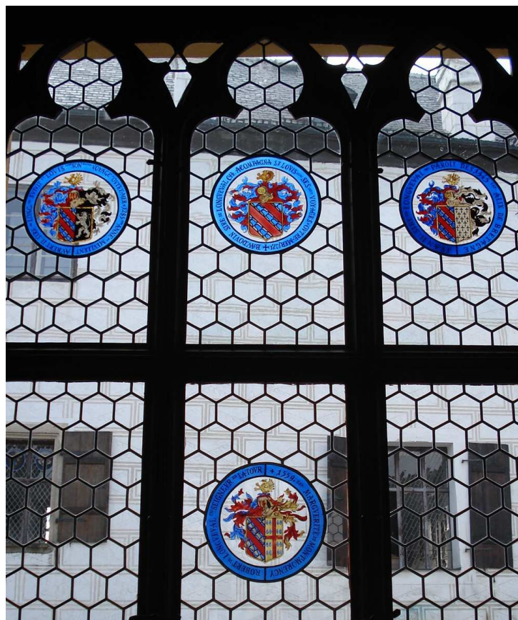
Obr. 26: Křižácká galerie v Rožmberku nad Vltavou: Současný stav vitrážového okna
