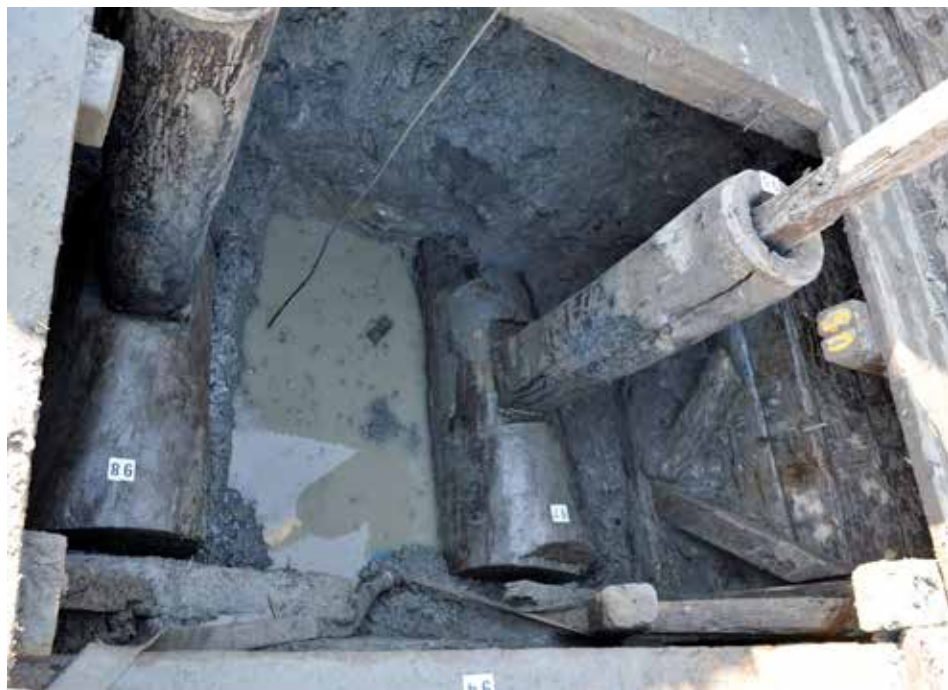
Obr. 16. Tábor – Jordán. Severní spodní výpusť – svislé vrtané roury (č. 95 a č. 96), které byly uzavírány čapy, dosedaly dole na otvory v horní ploše vodorovných výpusťných rour (č. 97 a 98). Vpravo je patrná vydřevená stěna spodní komory. Abb. 16. Tabor – Jordan-Stausee. Nördlicher unterer Ablass – die senkrechten durchbohrten Röhre (Nr. 95 und Nr. 96), die mit Zapfen geschlossen wurden, saßen unten auf den Öffnungen in der oberen Fläche der waagerechten Ablassrohre auf. (Nr. 97 und 98). Rechts ist die ausgezimmerte Wand der unteren Kammer zu sehen.
