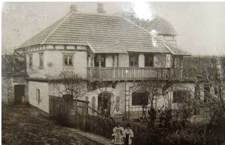
Obr. 6 Dům v Hroznové Lhotě – po Jurkovičově přestavbě
