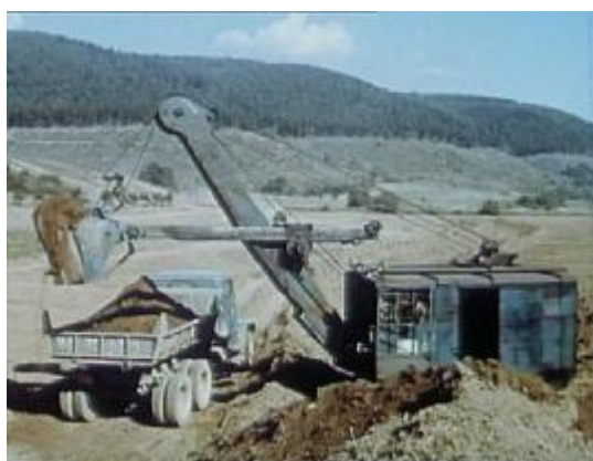
Obrázek 25. a 26. Odvoz hlíny ze zátopového území.
