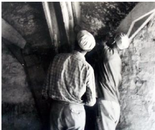
Obrázek 31. Červená nad Vltavou, práce při rozebírání kostela Svatého Bartoloměje.
