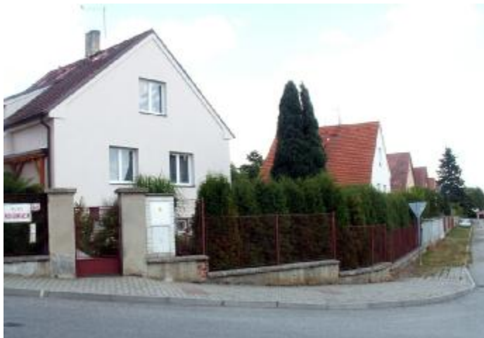
Obrázek 52. Týn nad Vltavou, ulice Pod Semencem postavená pro lidi z místních demolovaných čtvrtí.
