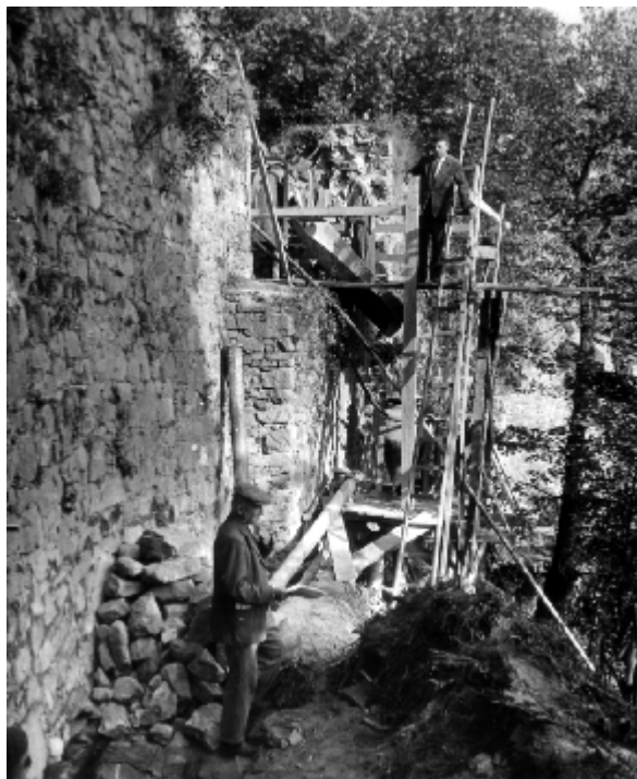
Obrázek 28. Zvíkov, zajišťovací práce na východní hradební zdi v roce 1959.
