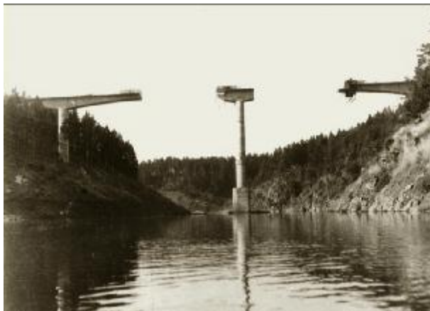
Obrázek 27. Stavba zvíkovského mostu bez lešení.
