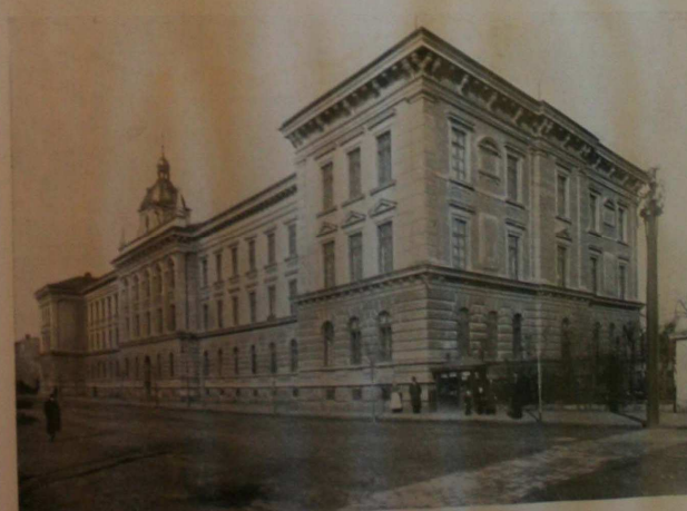
Foto Vlasák, Č. Budějovice. Městský chudobinec postavený v letech 1897—98 nákladem Českobudějovické spořitelny a věnovaný městu Č. Budějovicům. (Příloha 4.)
